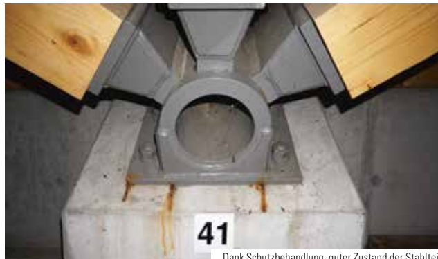
Dank Schutzbehandlung: guter Zustand der Stahlteile
