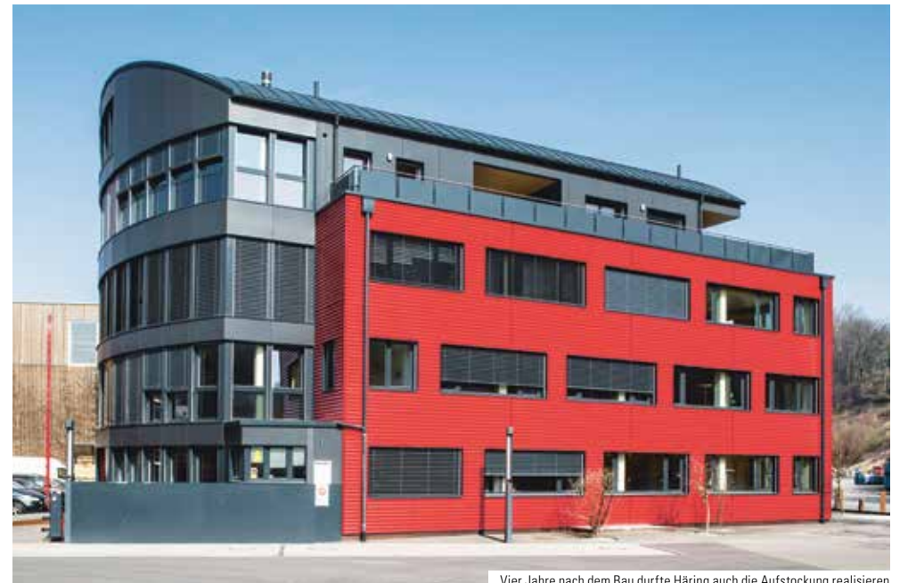
Vier Jahre nach dem Bau durfte Häring auch die Aufstockung realisieren
