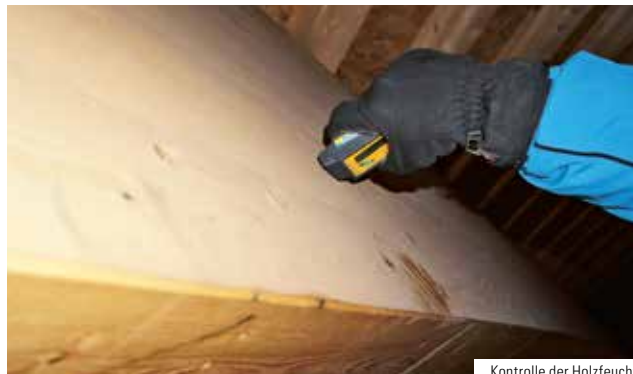
Kontrolle der Holzfeuchte
