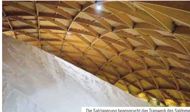
Die Salzlagerung beansprucht das Tragwerk des Saldome 2
