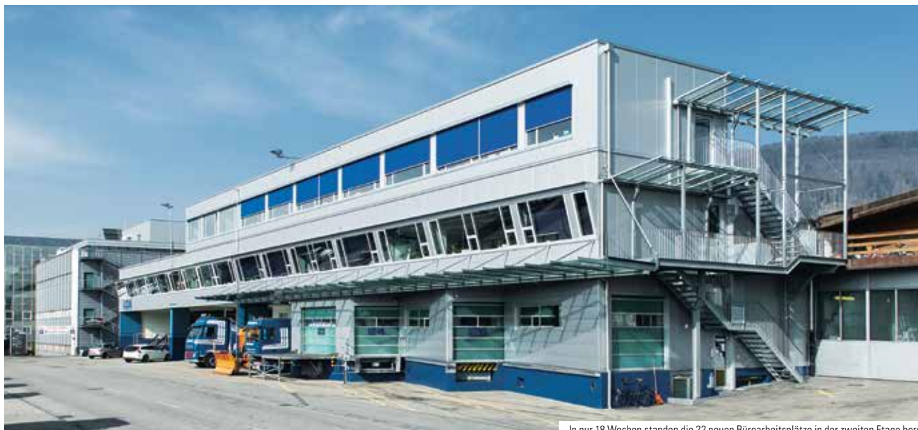
In nur 18 Wochen standen die 22 neuen Büroarbeitsplätze in der zweiten Etage bereit
